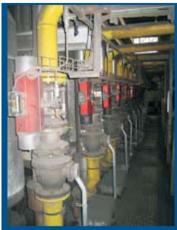
Шаровые краны КНА с пневмоприводами
