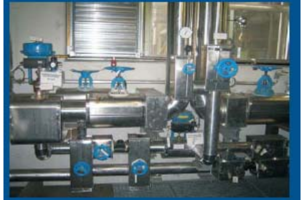
Вентили KVN с изоляцией, управление при помощи штурвала или пневмопривода, используются для регулирования давления пара
