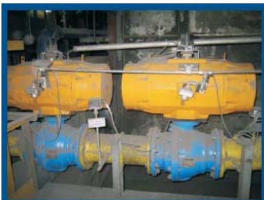
Шаровые краны Баллостар КНІ, оснащенные электро-механическими приводами
